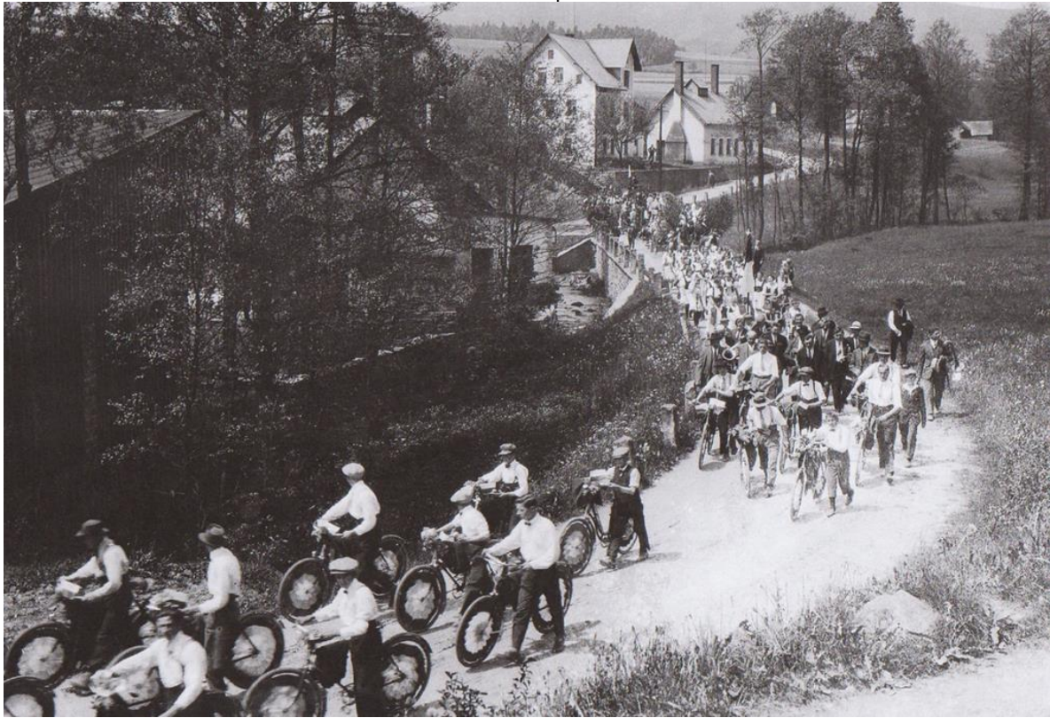
Pohled na silnici kolem potoka za hasičárnou
