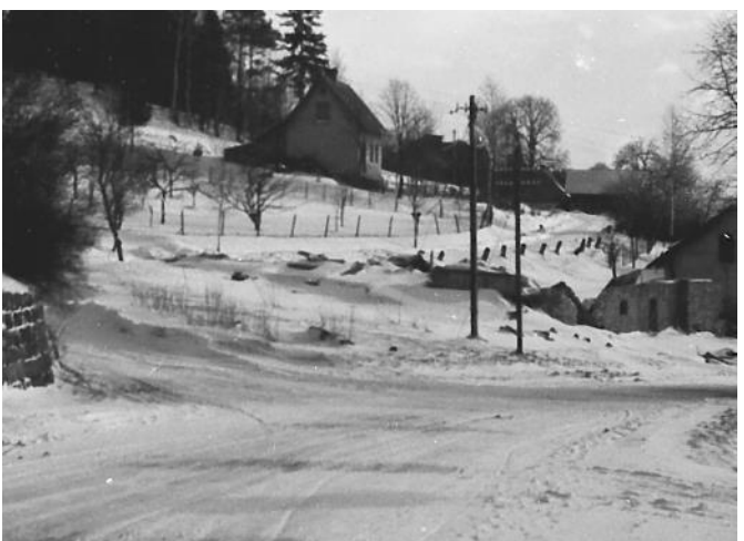
Takto vypadal pozemek po zbourání Sokolovny rok cca 1955
