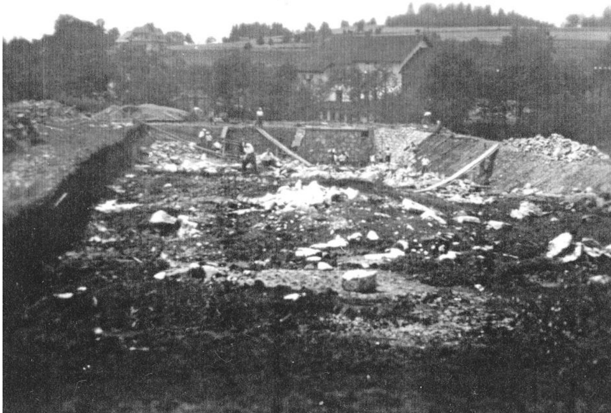
Stavba Loužnického koupaliště
