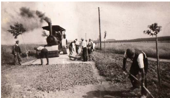
Stavba silnice Loužnice – Držkov
