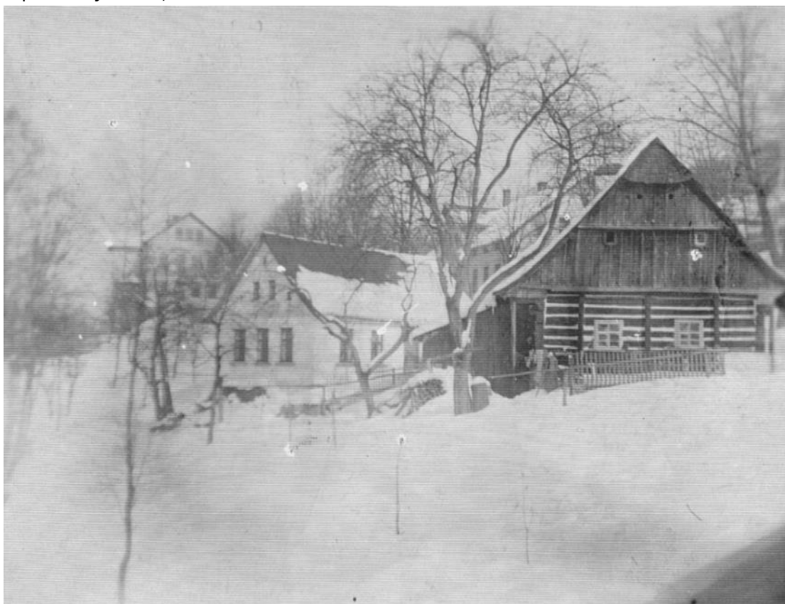
Foto: pohled na školu od chalupy, která stávala pod hlavní silnicí
