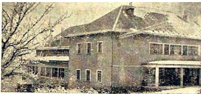
Záběr z výstavby Kulturního domu v Loužnici.
